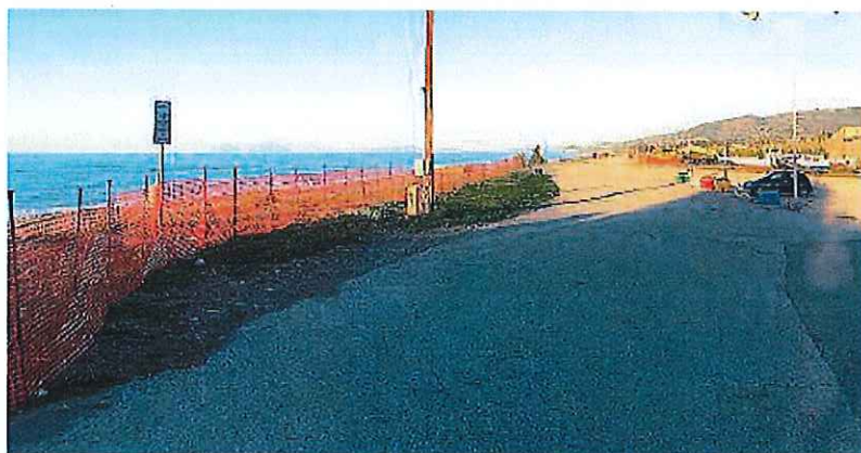
L'area recintata Presto in arrivo i mezzi della ditta Ricciardello
