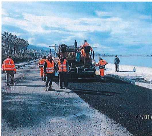
I lavori di rifinitura stradale. L'appalto affidato all'impresa Ricciardello
