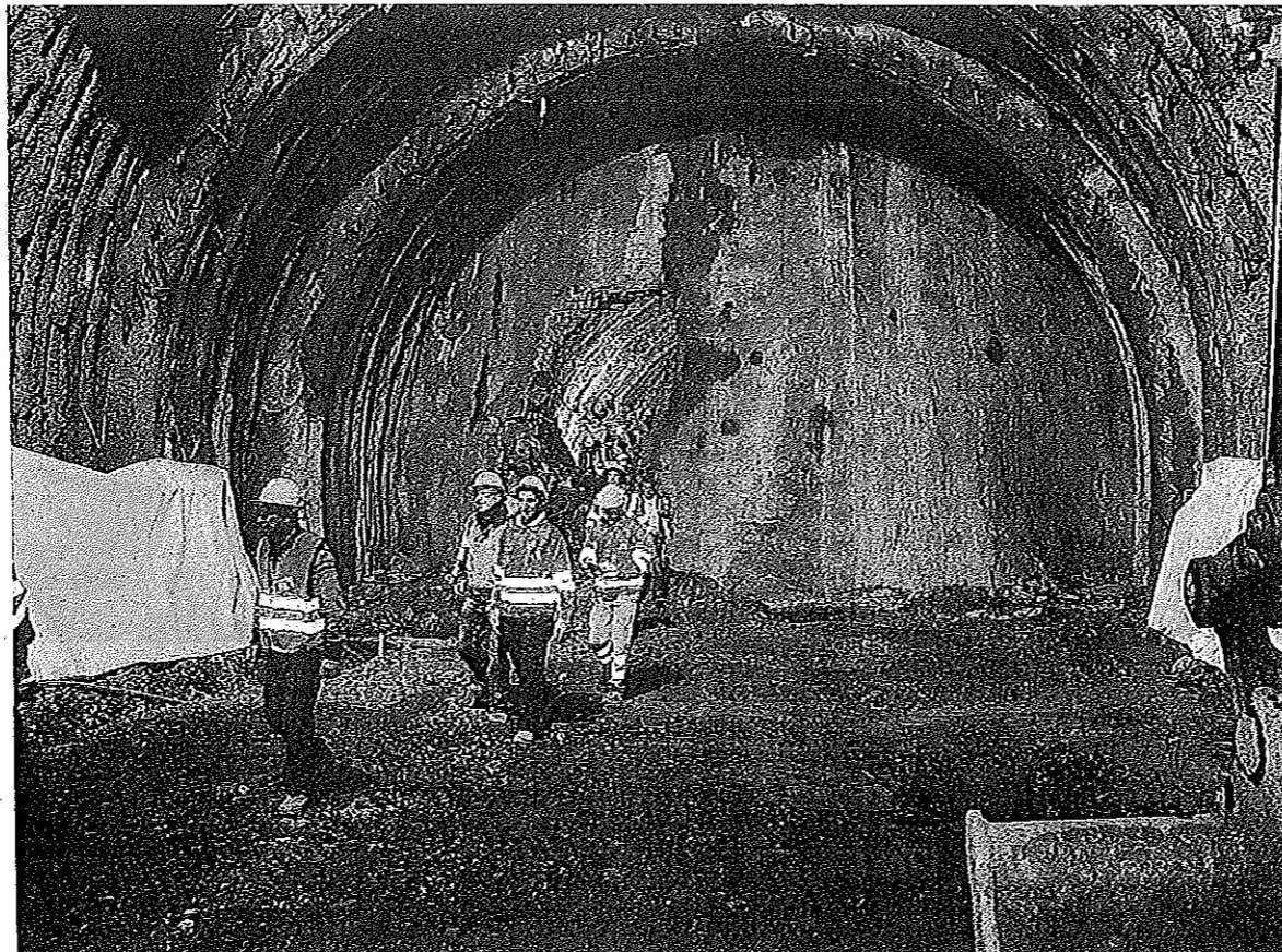
Operai ieri in galleria prima dell'abbattimento del diaframma (FOTO PUGLISI)
