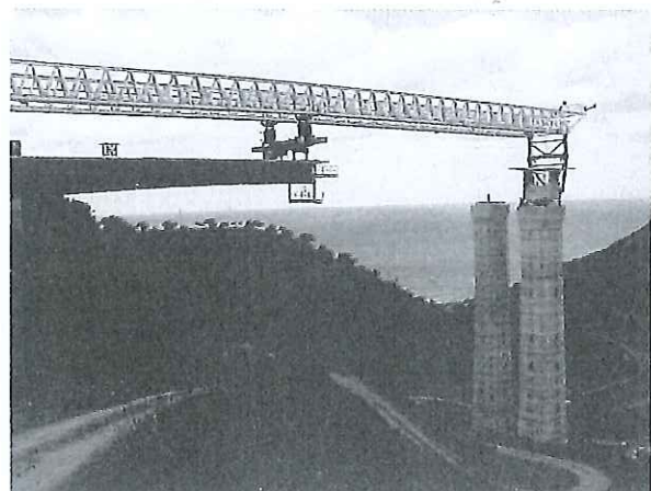
Fig. 3. Posizionamento del primo conio sulla pila
